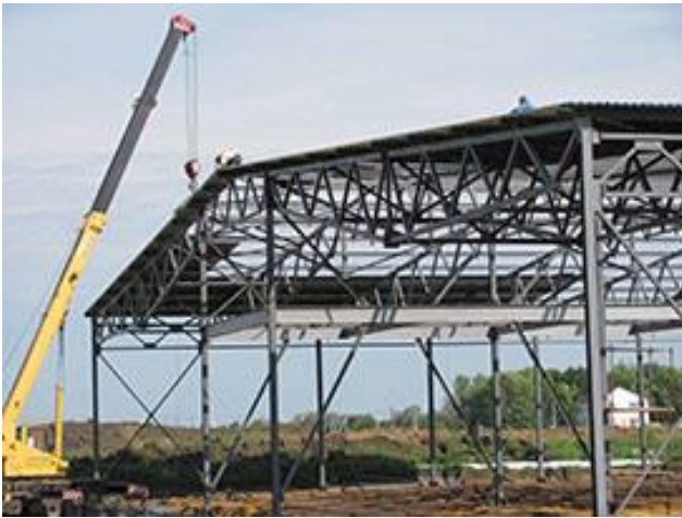
На фото: приклад зведення подібного овочесховища каркасного типу с металоконструкцій
