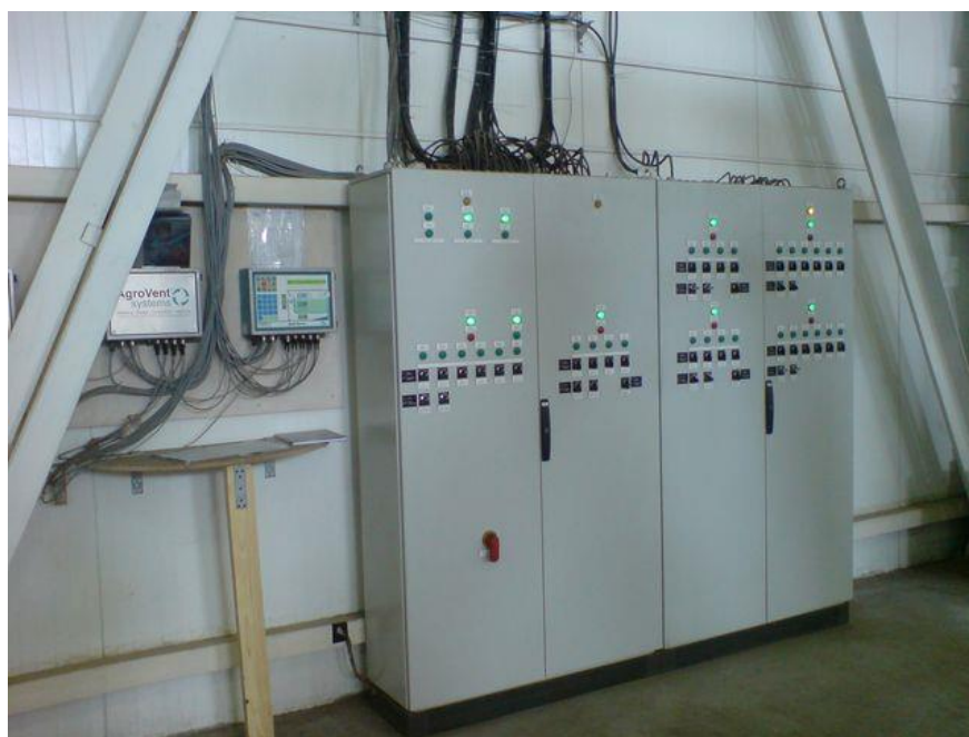
На фото: Обладнання для управління системою мікроклімату в овочесховищі
